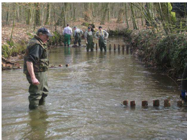
Aanbrengen van 'dood-hout vangers' en kiezelbedden.
