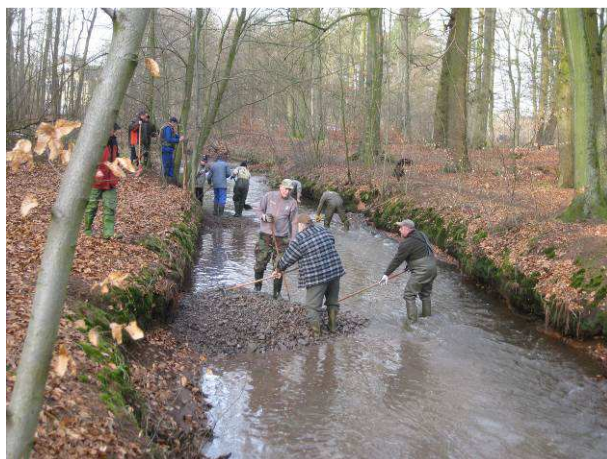
Aanbrengen van 'dood-hout vangers' en kiezelbedden.
